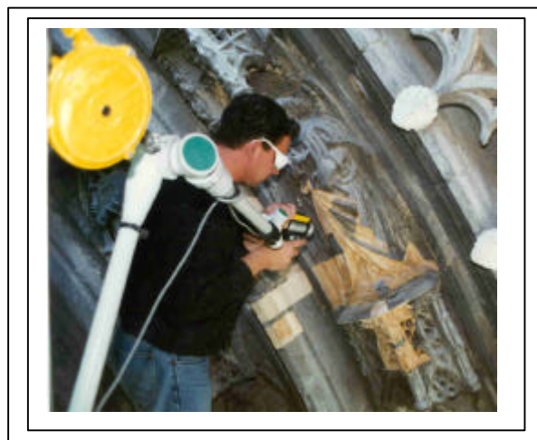
Photo 3 : essai de nettoyage laser en cours sur un claveau sculpté (étude préalable à la restauration du portail nord de l'église Saint Michel de Bordeaux).
