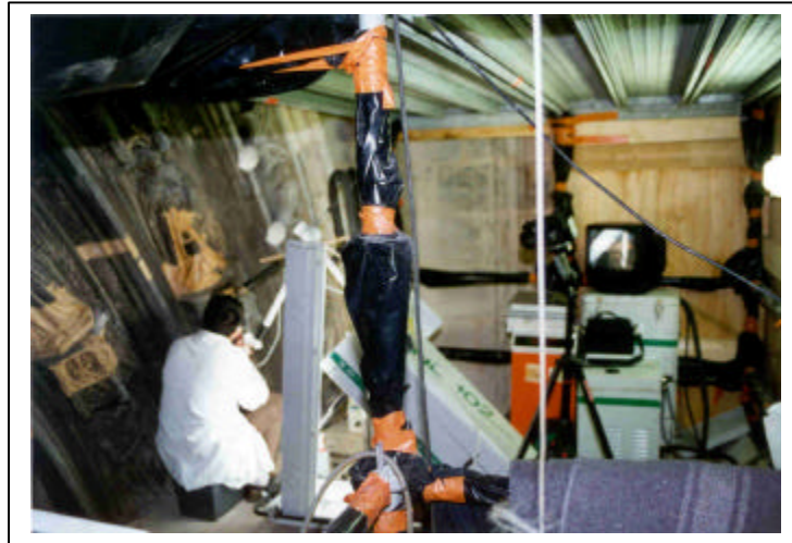
Photo 5 : intérieur de l'aire de travail sur un chantier de nettoyage laser (restauration du portail nord de l'église Saint Michel de Bordeaux).
